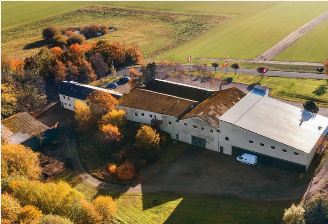
Nedkørsel til Nordfacade med stor port & loftshøjde
